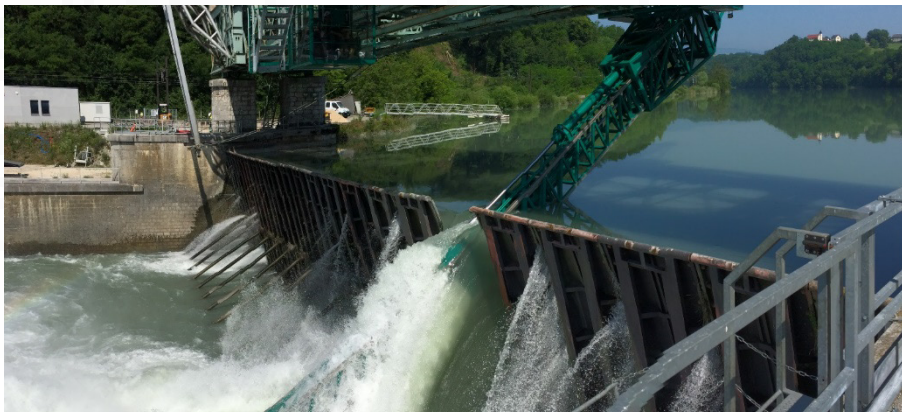
Maneuvered doors to manage water circulation Portes manœuvrées pour gérer la circulation de l'eau Bedienung der Schleusen und Dämme zur Wasserregulierung.
